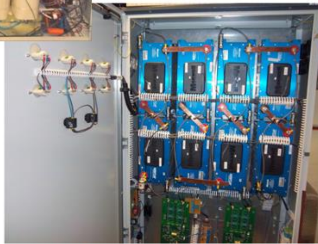
Supercapacitor Charger (Subsystem 1)
